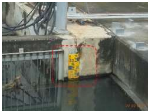
รูปที่ 20 (ต่อ) การติดตั้งเครื่องสูบน้ำและบรรทัดวัดระดับน้ำของโครงการ
