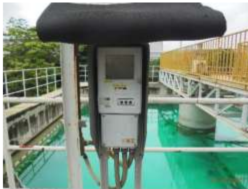
รูปที่ 13 การติดตั้ง COD Online บริเวณระบบบำบัดน้ำเสีย
